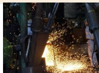
「溶接現場での体調管理」 (濱中製鎖工業(株) 提供)
